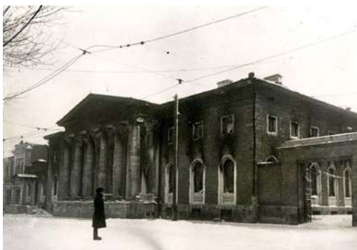
Здание Пятигорского бальнеологического института, 1943 г.
